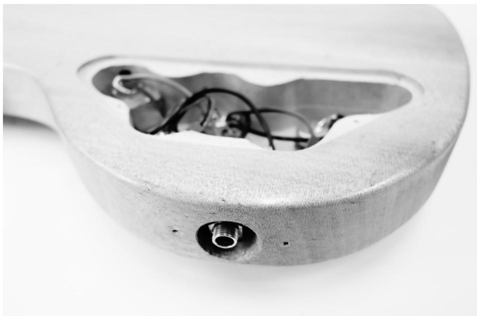
Inserte el soporte para el terminal de conexión y controle el extremo saliente del terminal. Este debe sobresalir lo suficiente como para poder atornillarlo con la tuerca suministrada, pero solo debe sobresalir lo mínimo. Dado el caso, corrija el extremo saliente, girando la contratuerca por del interior.
